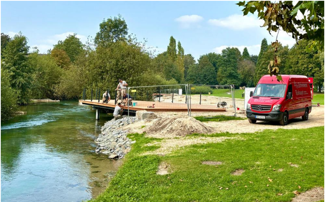
Errichtung eines Stegs im Paderauenpark
